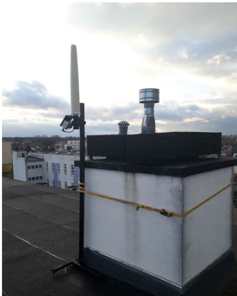
Rys. 3 Miejsce montażu SMS PEM – Ostrowska 6, Włocławek
